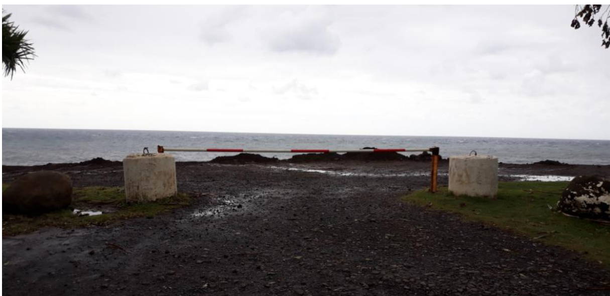
Entrée du site de Champ Borne depuis la route départementale 47 (Saint-André)
