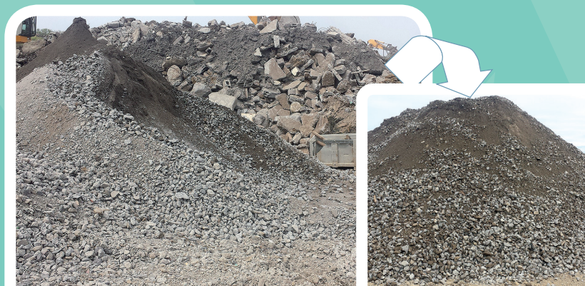
Concassage et criblage des croûtes d'enrobés.
